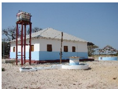
Centro com o poço e depósito elevado
