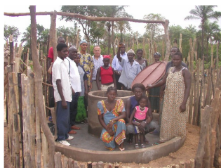
Poço de Água em Bolom
