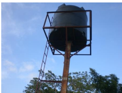
Depósito elevado de água para a maternidade
